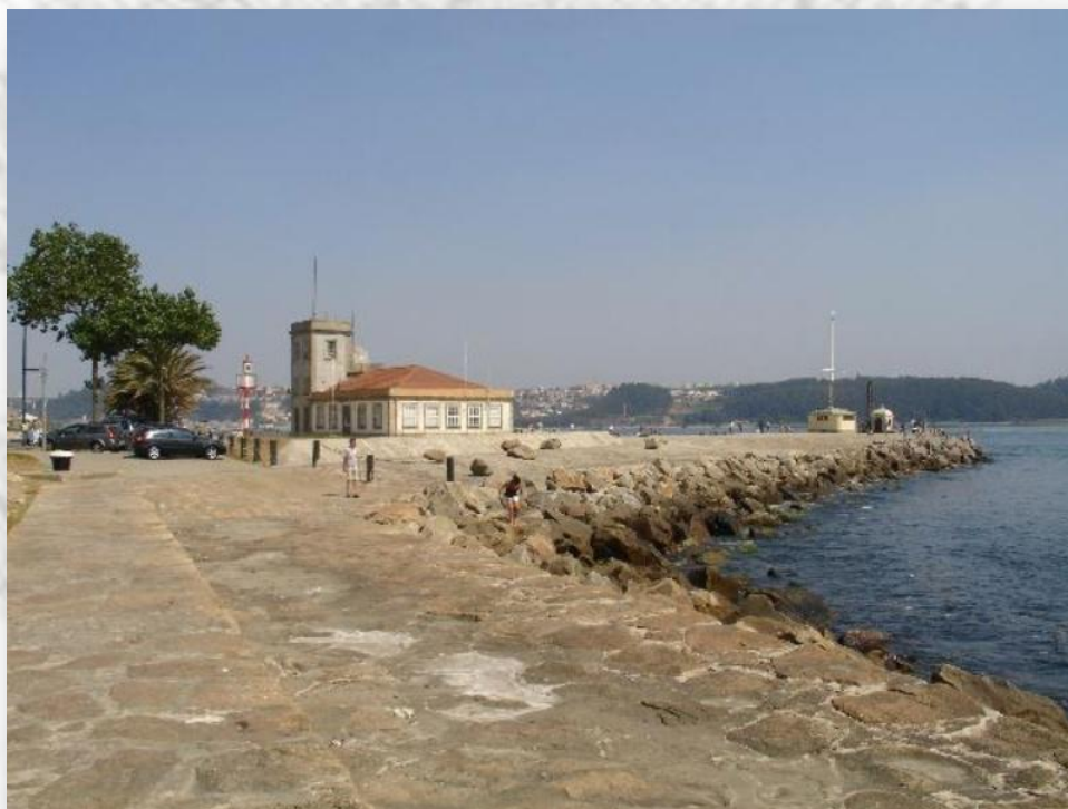
Figura 13 – Foto da Capela S. Miguel o Anjo - nas margens do Douro, hoje semi-entaipada por construções posteriores, apresenta secção oitava no interior.
